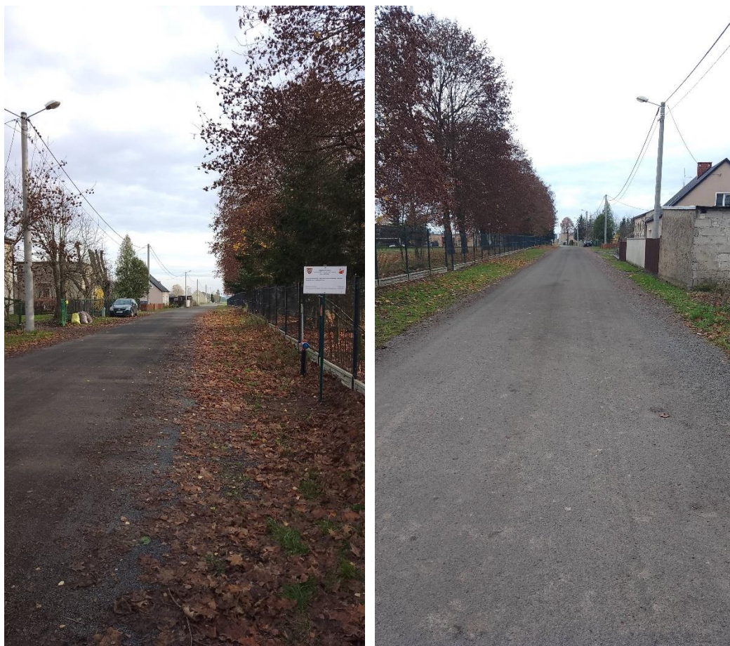
Fot. Emulsjonowanie drogi w Kleszczynie.
